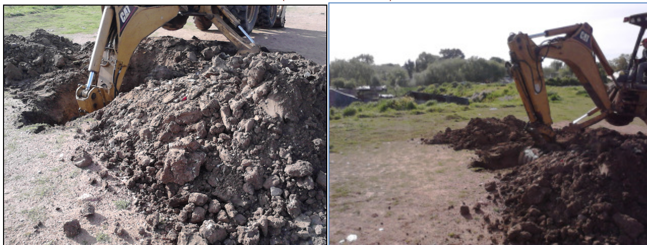
ILUSTRACIÓN 3 - REALIZACIÓN DE CALICATAS EMPLEANDO RETROEXCAVADORA COMBINADA EN ZONA DE RELLENO (ANTIGUA CANTERA)
